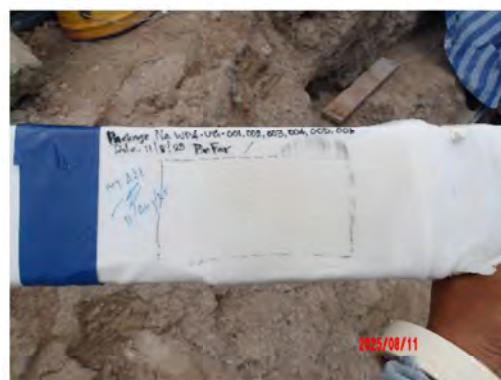
ภาพที่ 2.2-5 การทำ Hydrostatic Test (การใช้ตะแกรงหรือผ้าขาวบางรองรับน้ำ)
